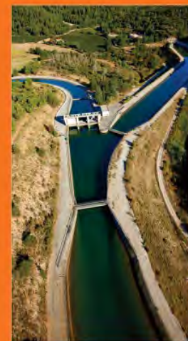
La prise de Boute à Ghosauxville (Verdon) alimente 5 ans le littoral du grand littoral de la C.C.P. et à droite le canal EDF alimentant la centrale de Vinon.
