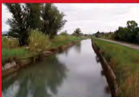
Le canal de Crapeonne (Bouches-du-Rhône)
